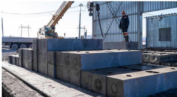
Разрез «Березовский» (АО «СТРОЙСЕРВИС»)
