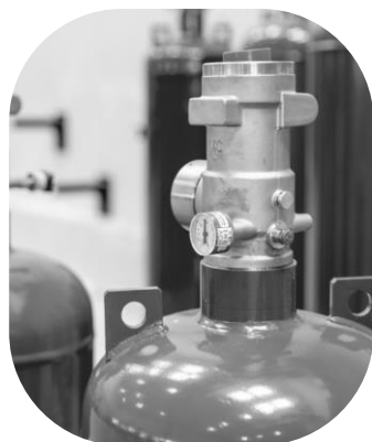
Модули газового пожаротушения
