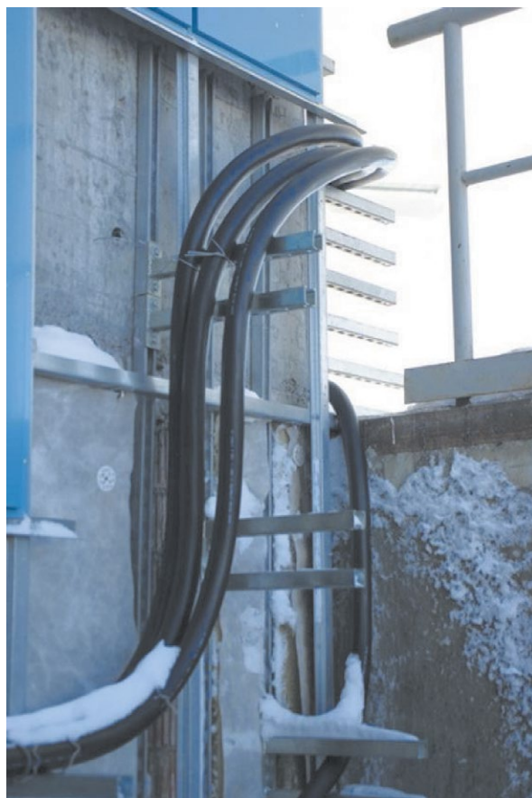
Применение консолей КН на здании для временной поддержки кабеля
